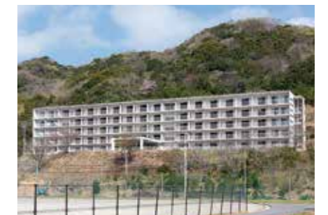
川薪寮(堂ノ浦キャンパス・2020年3月新設)
